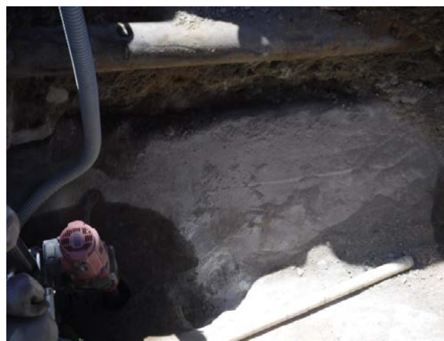
1か所目 無筋コンクリート
