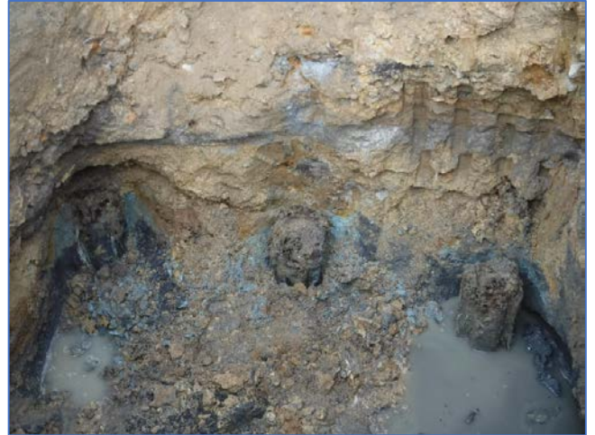
No.1 中間立坑設置前試掘状況(木杭確認)
