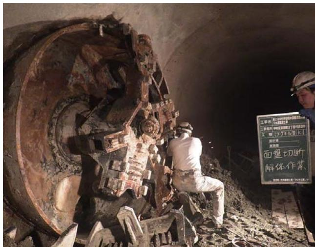
掘進機面盤切断状況
