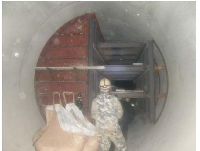
機内前方注入状況(シールド3m手前薬液改良)
