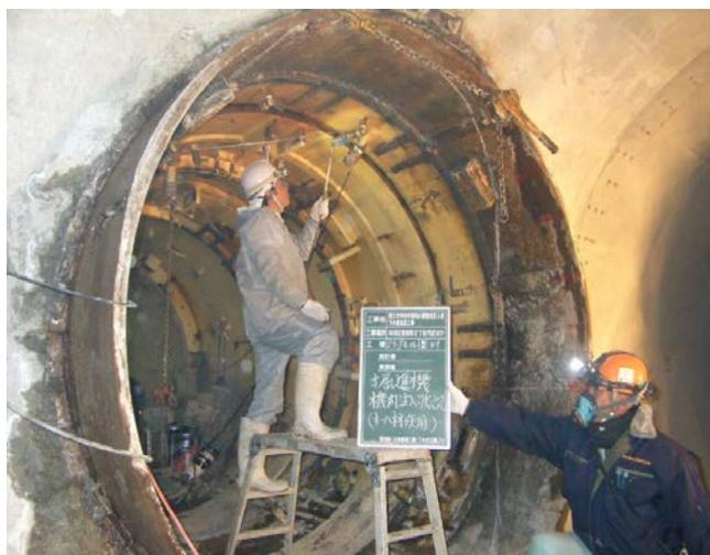
掘進機フード部 切断撤去状況
