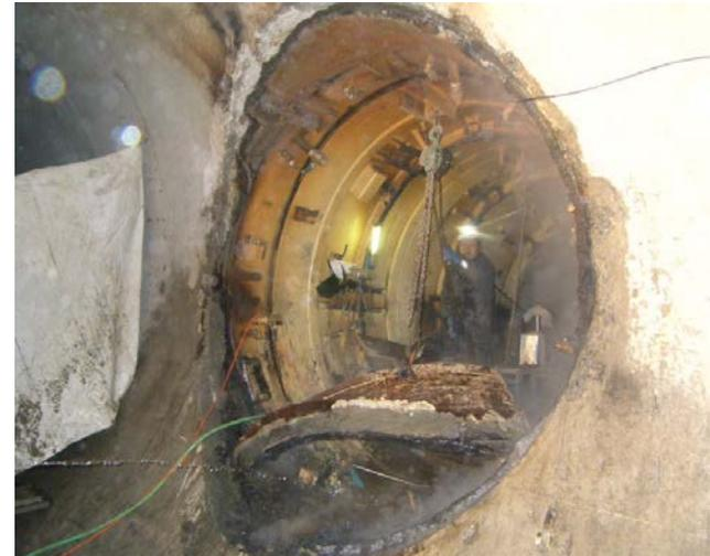
掘進機フード切断部エポキシ樹脂材塗布状況
