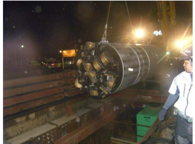
φ1000mmミリングモール掘進機
