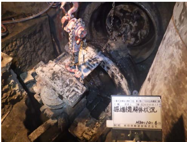
掘進機解体状况
