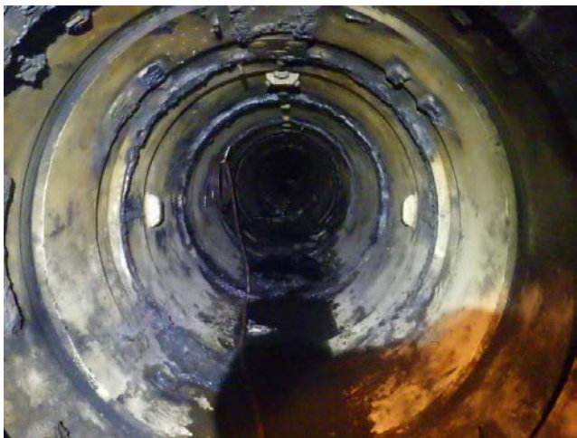
掘進機解体完了
