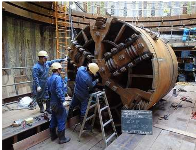
φ 2200mmミリングモール掘進機
