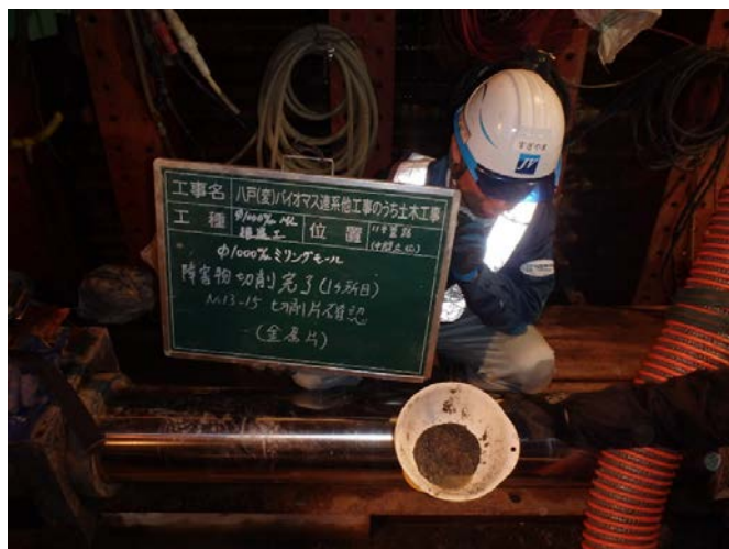
障害物切削 切削片確認(金属片)
