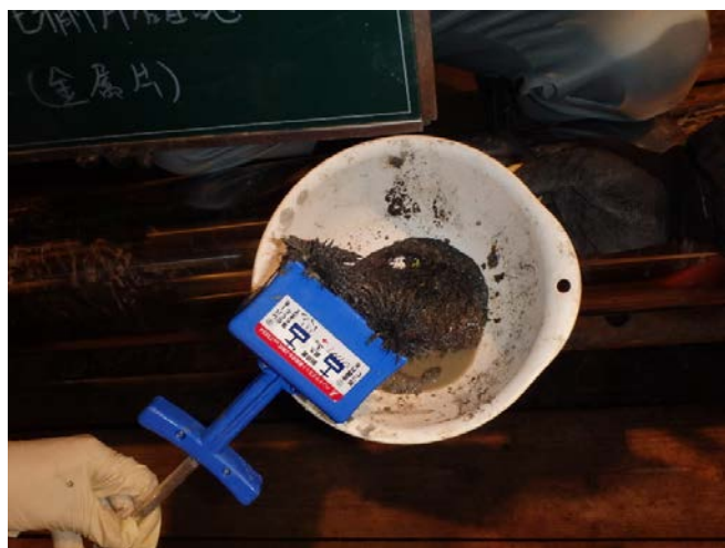
障害物切削 切削片確認(金属片)
