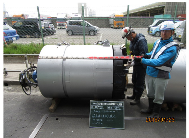
掘進機内(伸縮管)切削状況
