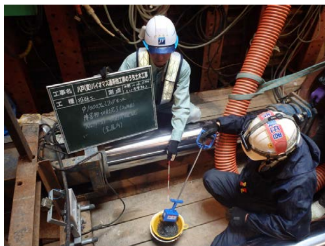
障害物切削 切削片確認(金属片)
