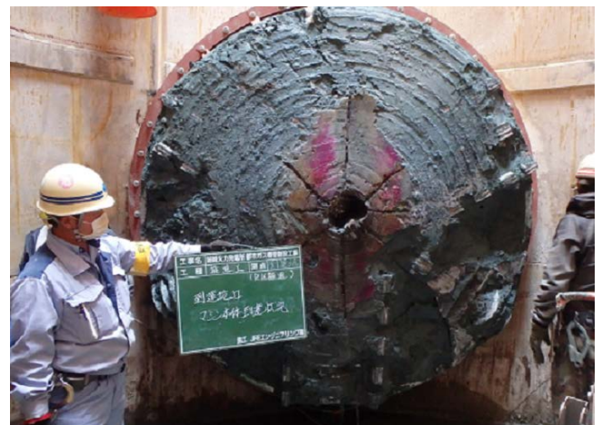
掘進機到達状況
