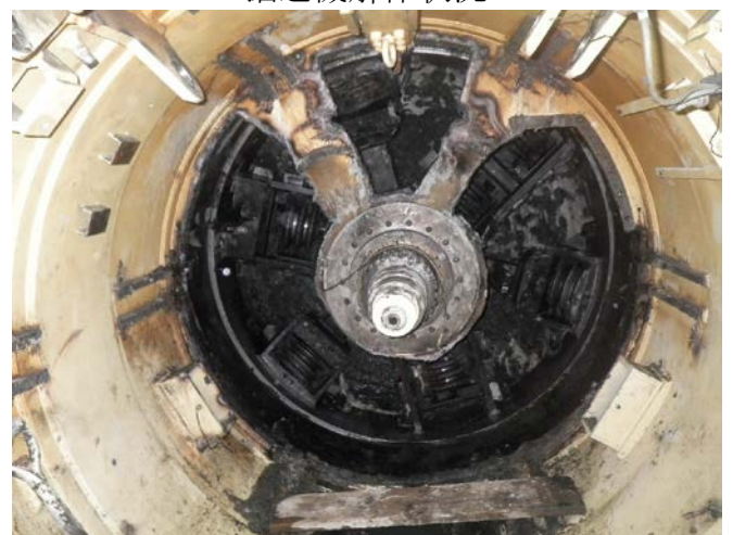
掘進機解体状況
