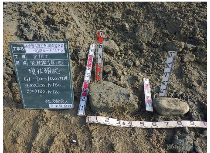
発進立坑掘削時の流木
