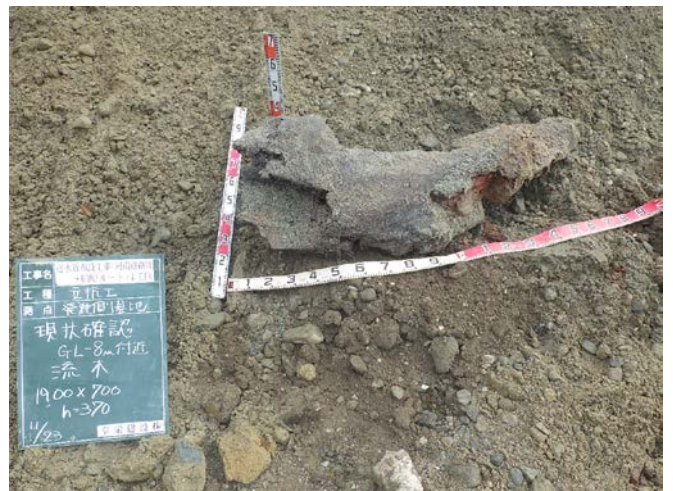
発進立坑掘削時の流木
