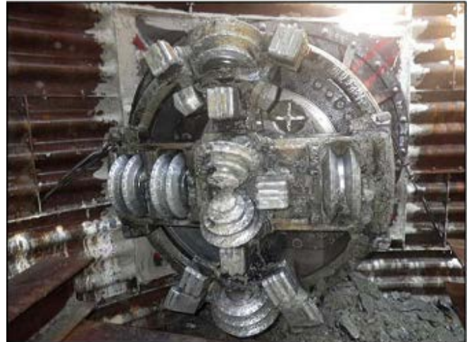
掘進機到達状況
