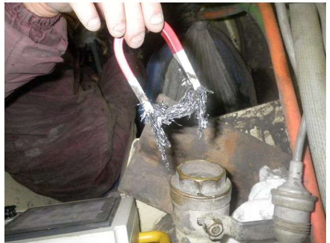
2013.11.7 鋼矢板切削粉排出 鉄粉収集状況
