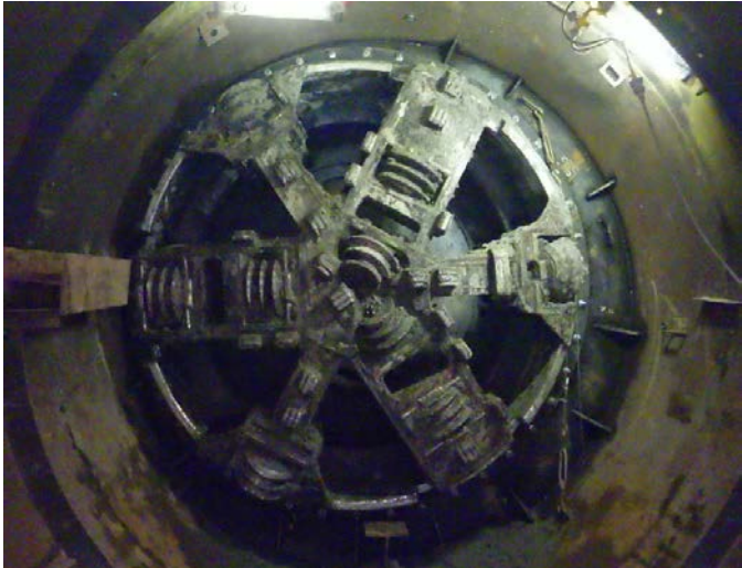
掘進機到達状況
