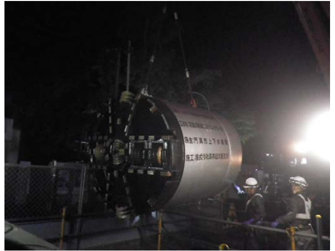
掘進機坑内吊り降ろし
