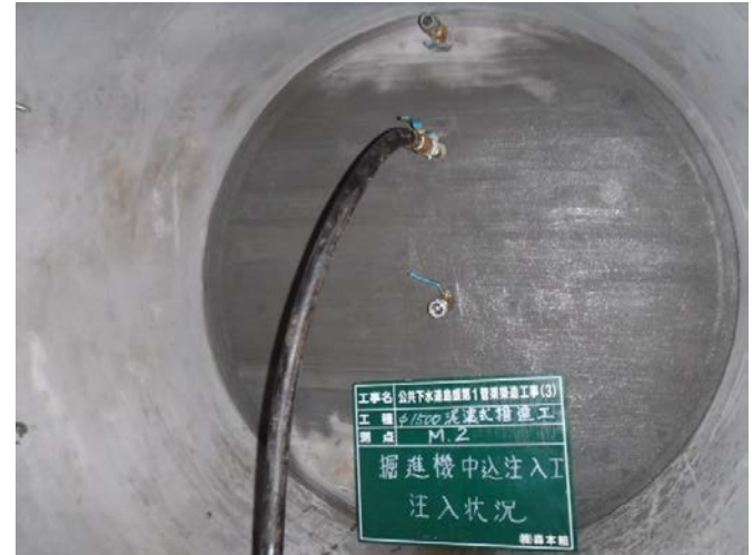
中込め注入を行って施工完了です
