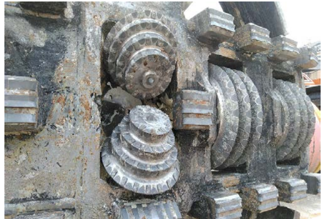
推進完了後カッタービット
