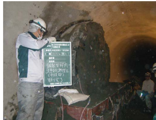
鋼製型枠内 流動化処理土 研り状況
