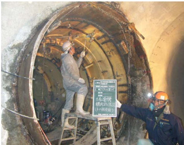
掘進機外周止水注入状況(OH注入)
