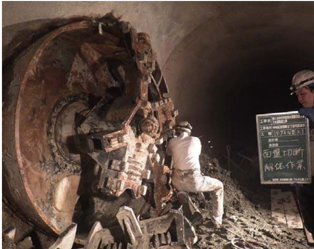
掘進機カッターヘッド切断状況
