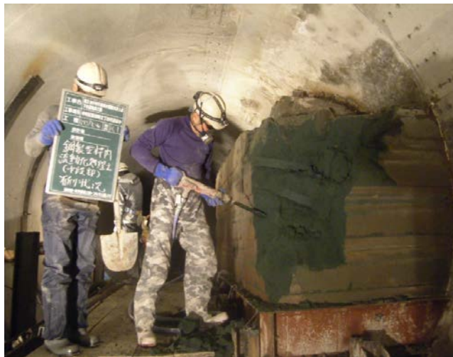
鋼製型枠内 流動化処理土 研り状況
