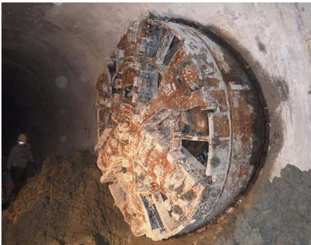
鋼製型枠内 流動化処理土 研り完了
