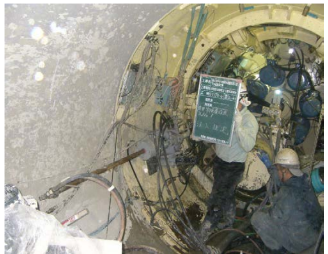
機内前方注入状況(シールド3m手前薬液改良)
