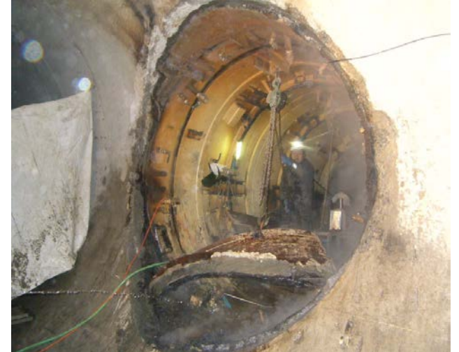
掘進機フード部 切断撤去状況
