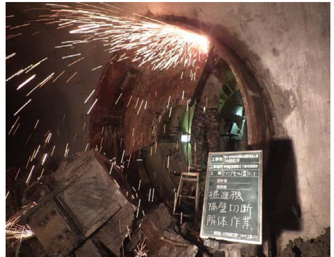
掘進機面盤切断状況
