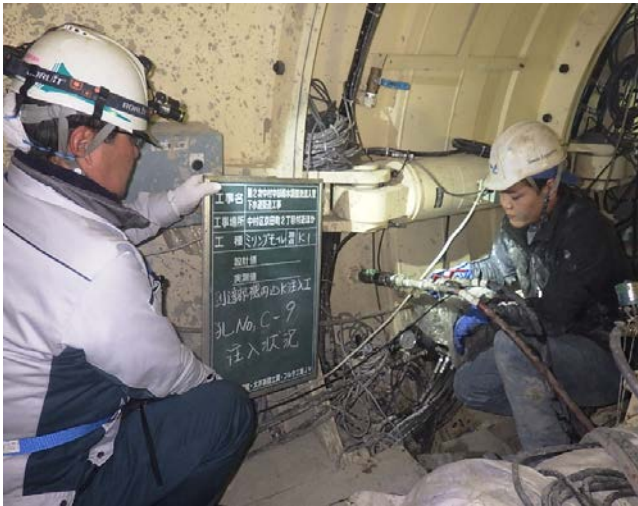
機内外周注入(既設シールド切削完了後)
