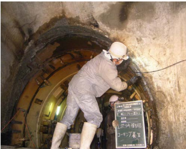
掘進機フード切断部エポキシ樹脂材塗布状況
