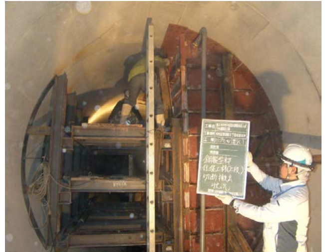
既設シールド内鋼製型枠撤去状況
