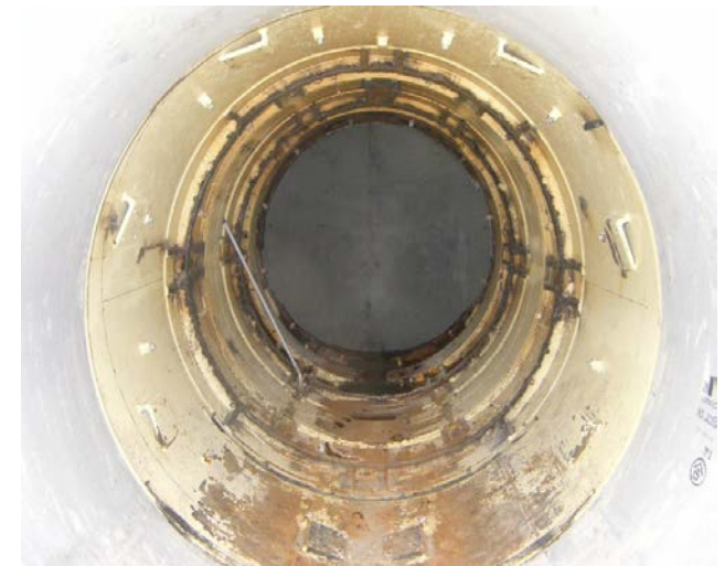
既設シールド到達工完了
