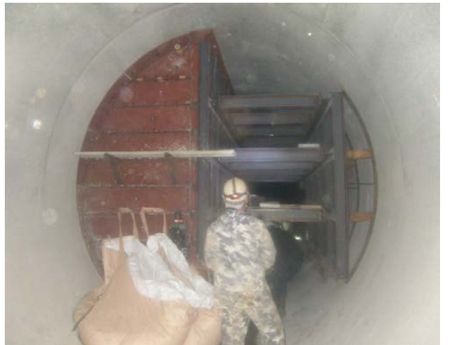
既設シールド内到達部 鋼製型枠全景
