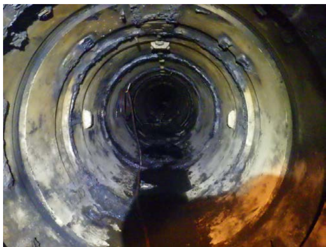
掘進機解体完了
