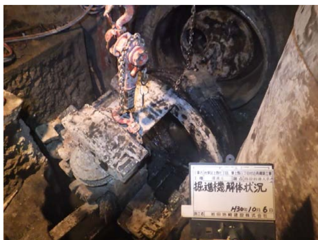
掘進機解体状況
