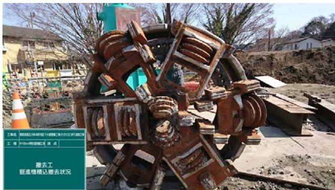
掘進機7分割回収(カッター部)
