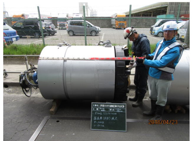
掘進機内(伸縮管)切削状況
