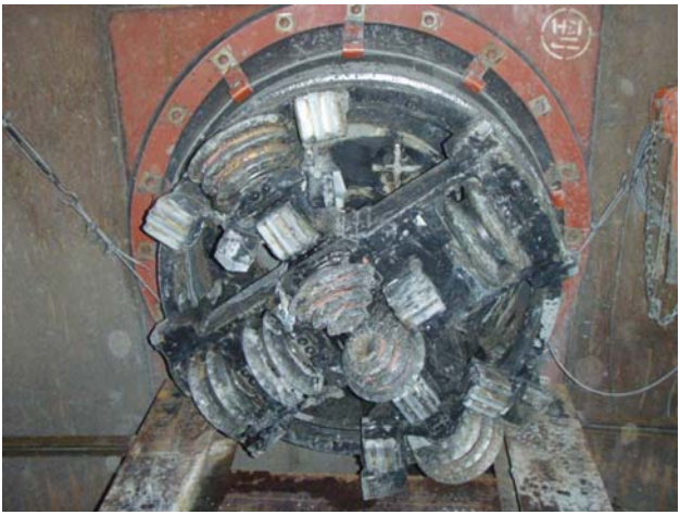
掘進機到達状況
