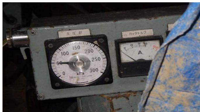
写3. 土圧管理状況 (薬液注入圧力管理)
