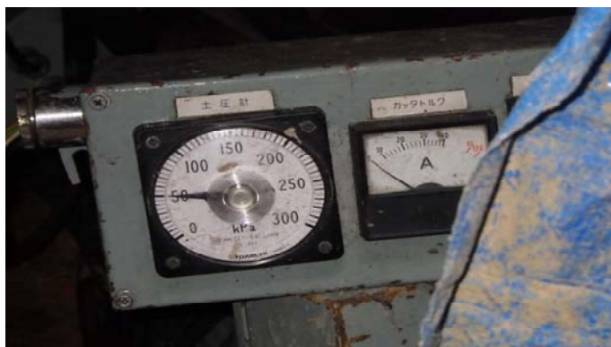
写3. 土圧管理状況（薬液注入圧力管理）
