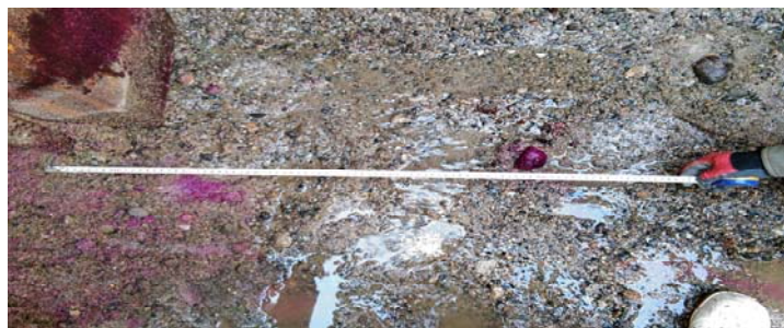
写7. 機内注入工法改良範囲検尺④
