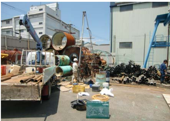
ボーリング調査
