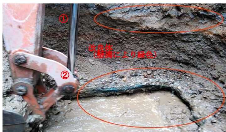
写9. 目視による改良範囲確認②
