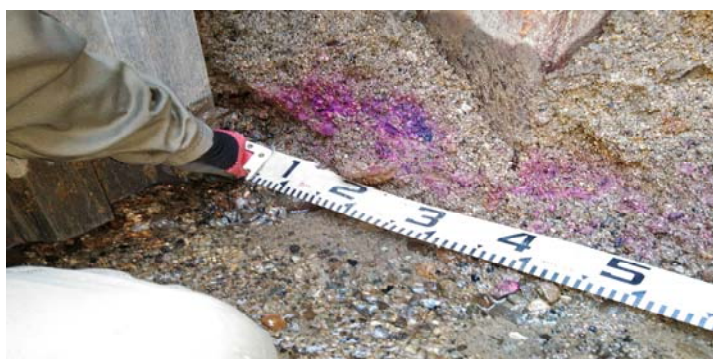
写5. 機内注入工法改良範囲検尺②
