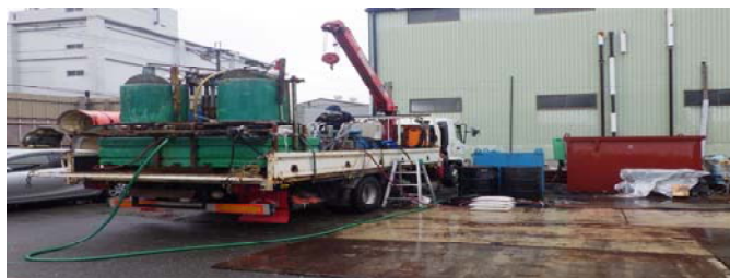
写1. 機内注入工法施工状況①（立坑上状況）
