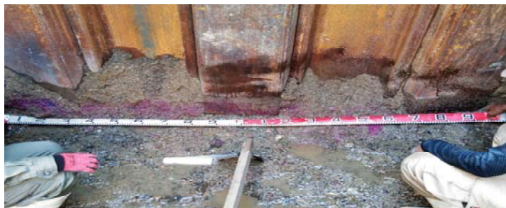
写4. 機内注入工法改良範囲検尺①
