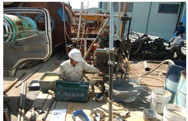
ボーリング調査
