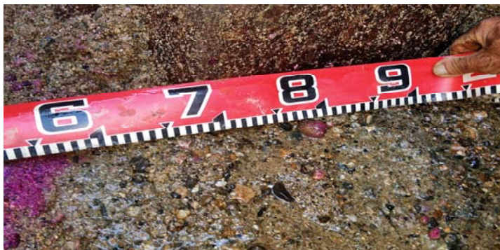
写6. 機内注入工法改良範囲検尺③
