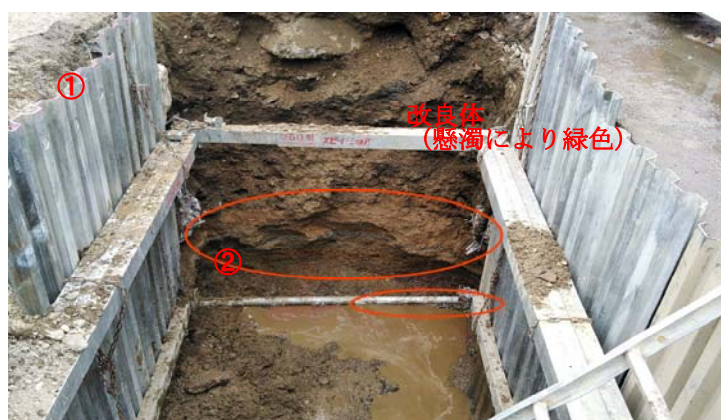
写8. 目視による改良範囲確認①
