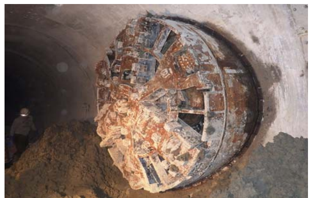
ミリングモール掘進機φ2200到達後、 ボイド止水、型枠撤去 流動化処理土ハツリ撤去後
