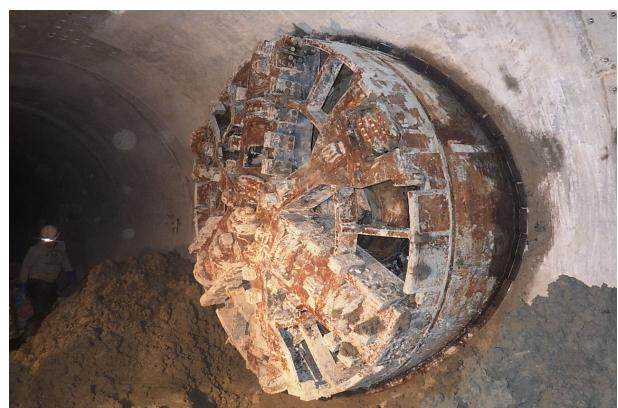
ミリングモール掘進機φ2200到達後、ボイド止水、型枠撤去
