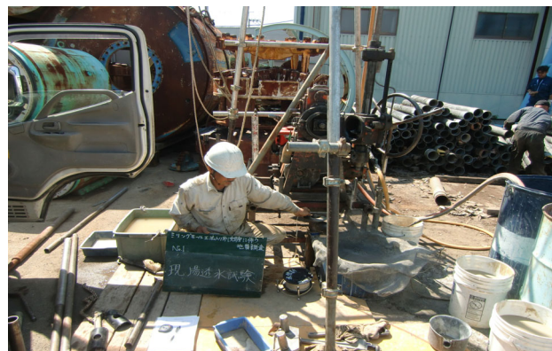
ボーリング調査
