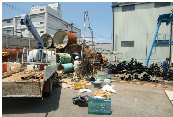
ボーリング調査
