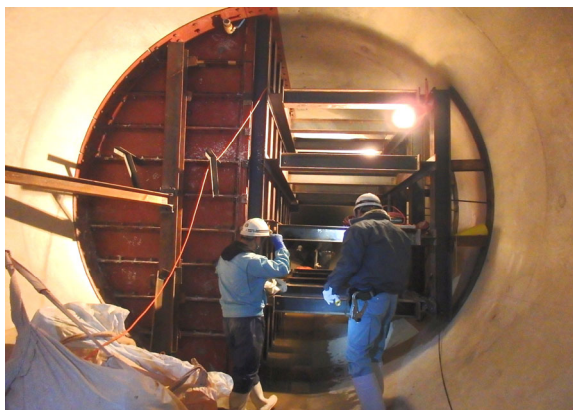
φ3750シールド内到達防護壁 φ2200用特殊型枠内流動化処理土 充填、支保工、養生中
