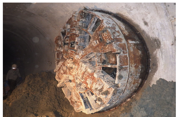
ミリングモール掘進機φ2200到達後、ボ イド止水、型枠撤去 流動化処理土ハツリ撤去後
