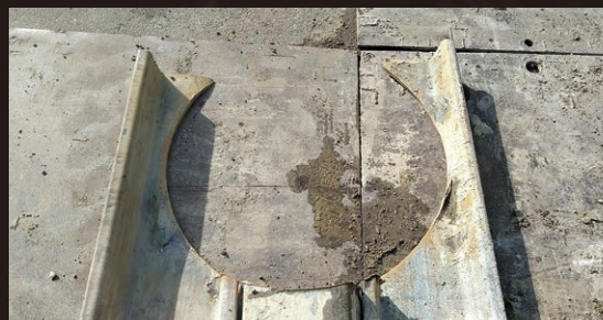
φ800ミリングモール掘進機による切削実験 直径φ990mmの切削円を確認
