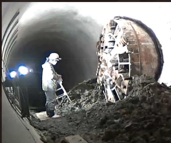
φ3750シールドへφ2200ミリングモール掘進機で鏡切を行わず、直接掘進機にて切削到達。到達後の詳細をご覧になりたい方はYouTubeでミリングモール工法を検索し、推進工事 名古屋φ2200ミリングモールをクリックしてください。
